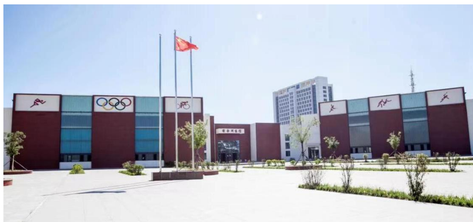
图 1 图 1-1：营口市体育运动学校综合训练馆
